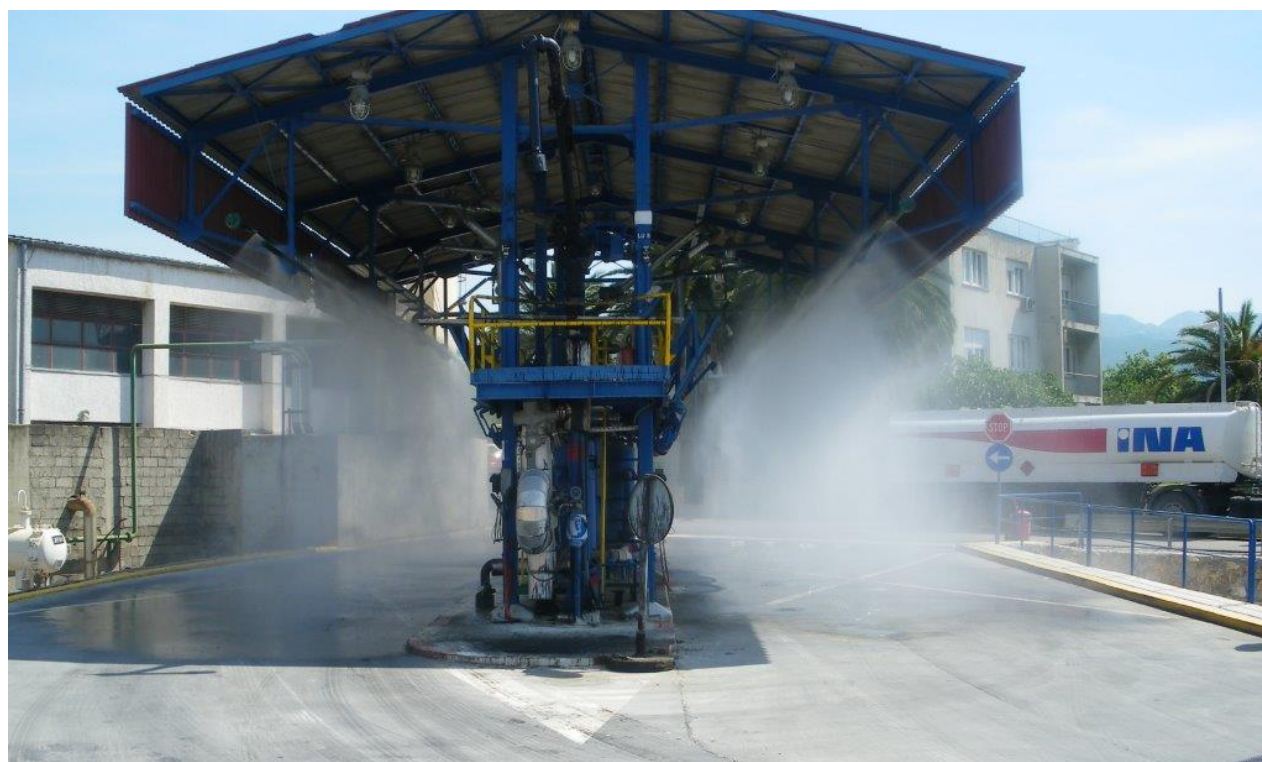
Slika 44. Autopunilište – Sveti Kajo, sustav zaštite od požara , sustav tehnološke kanalizacije postoji na čitavom području postrojenja. Elaborat o ispitivanju nepropusnosti dostupan je na lokaciji.
