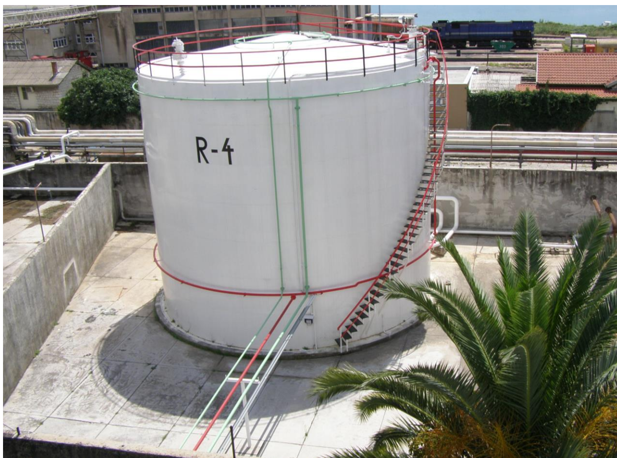
Slika 43. Spremnik R-4 (sustav zaštite od požara, zatvorena tankvana)
